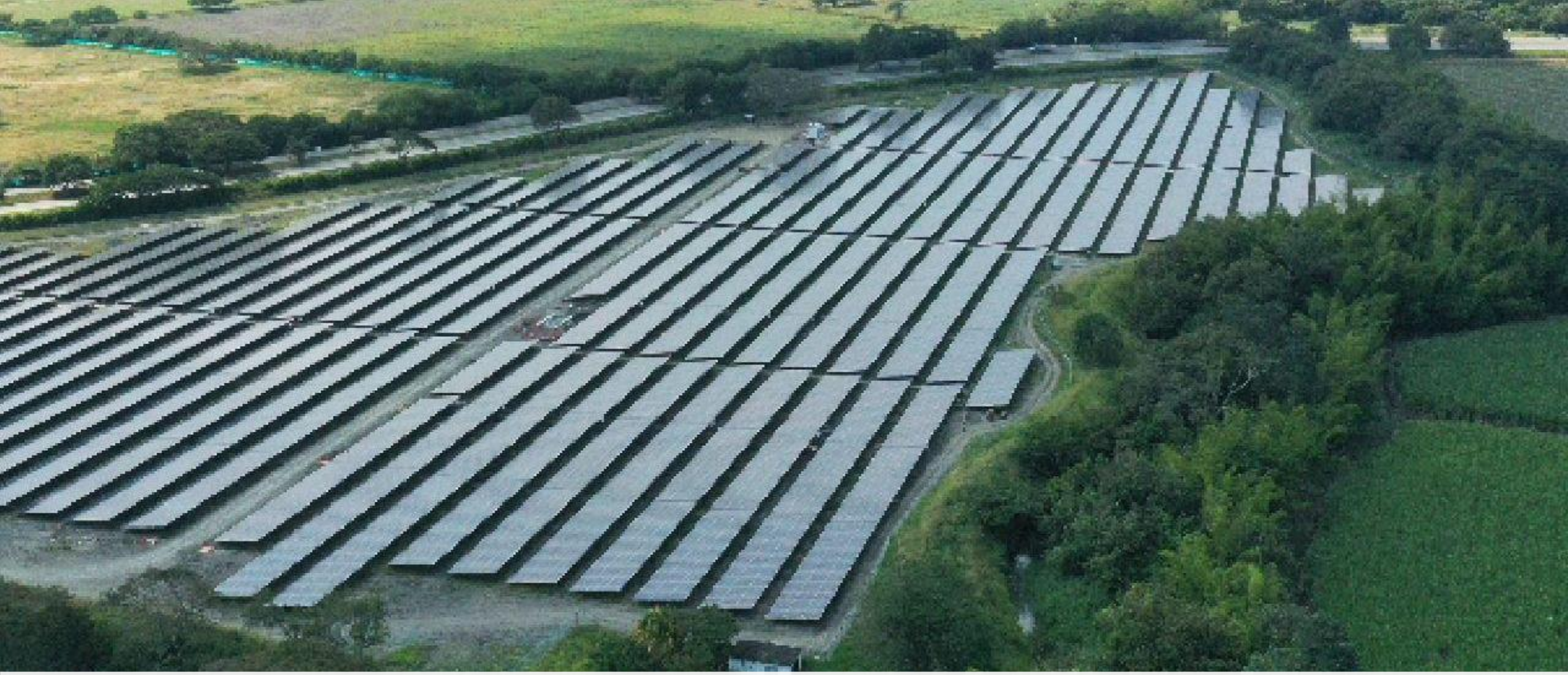
Foto Aérea Granja Solar – 6900 Paneles Solares
